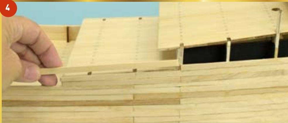
4 Вернемся к работе над кормовой частью левого борта. Вырежьте последнюю планку пояса обшивки, начатого в шаге 1. Форма, которую нужно придать этой планке, показана на фотографии. Сужающаяся часть планки не должна выступать над ахтердеком, а ее «ступенька» должна находиться на одной линии с передним краем расположенной выше палубы.
